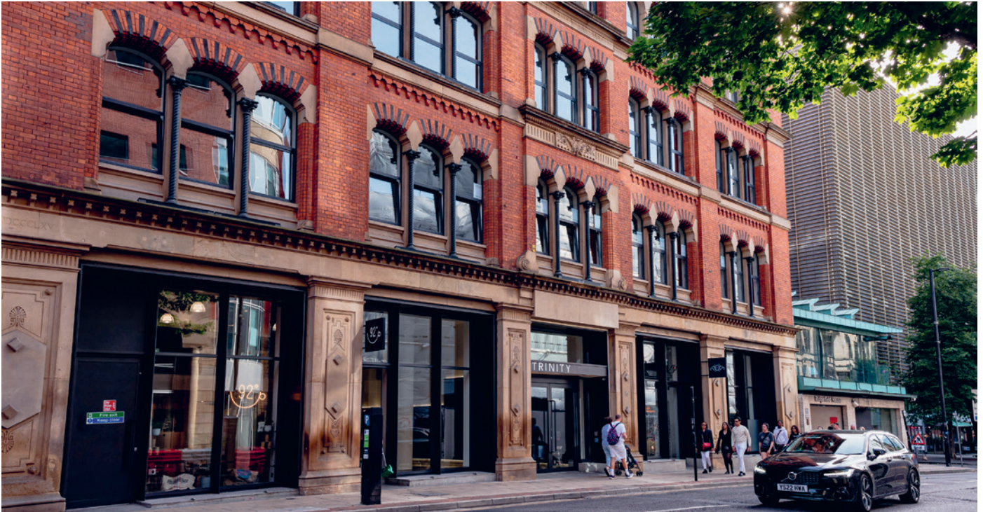
Hinter der historischen roten Backsteinfassade verbirgt sich modernste Gebäudetechnik. Quelle: Solid Ground
