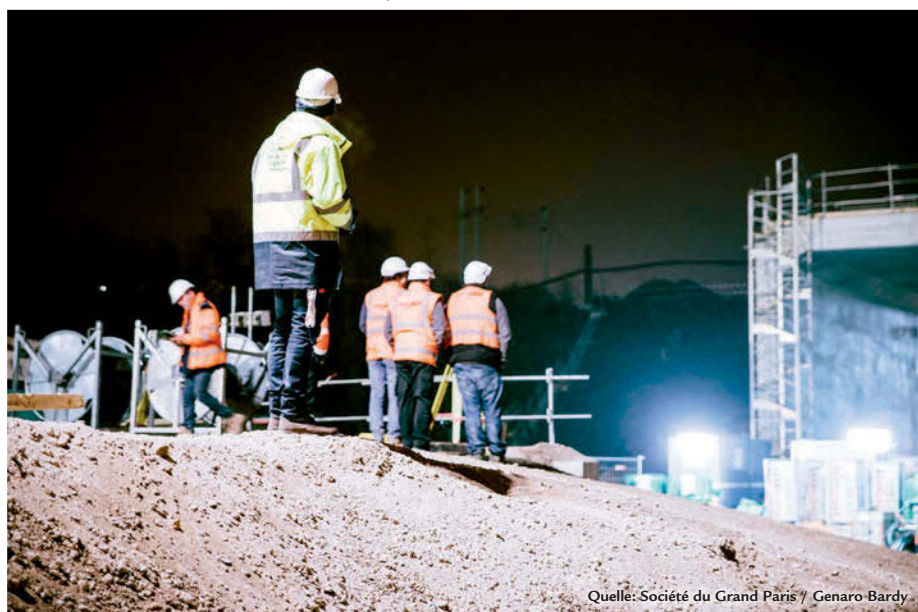
Baustelle der Metrostation «Porte de Clichy».
