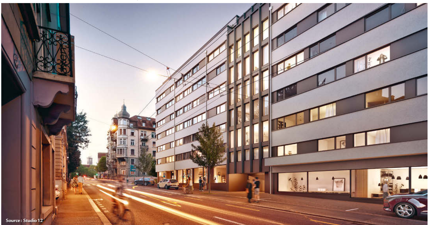
Wesemlinstrasse 2/4, à Lucerne: redensification par la construction d'un bâtiment accolé
