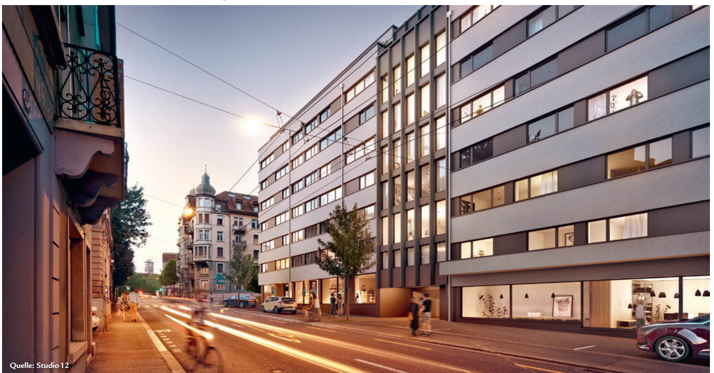
Wesemlinstrasse 2/4 in Luzern: Nachverdichtung durch Zwischenbau
